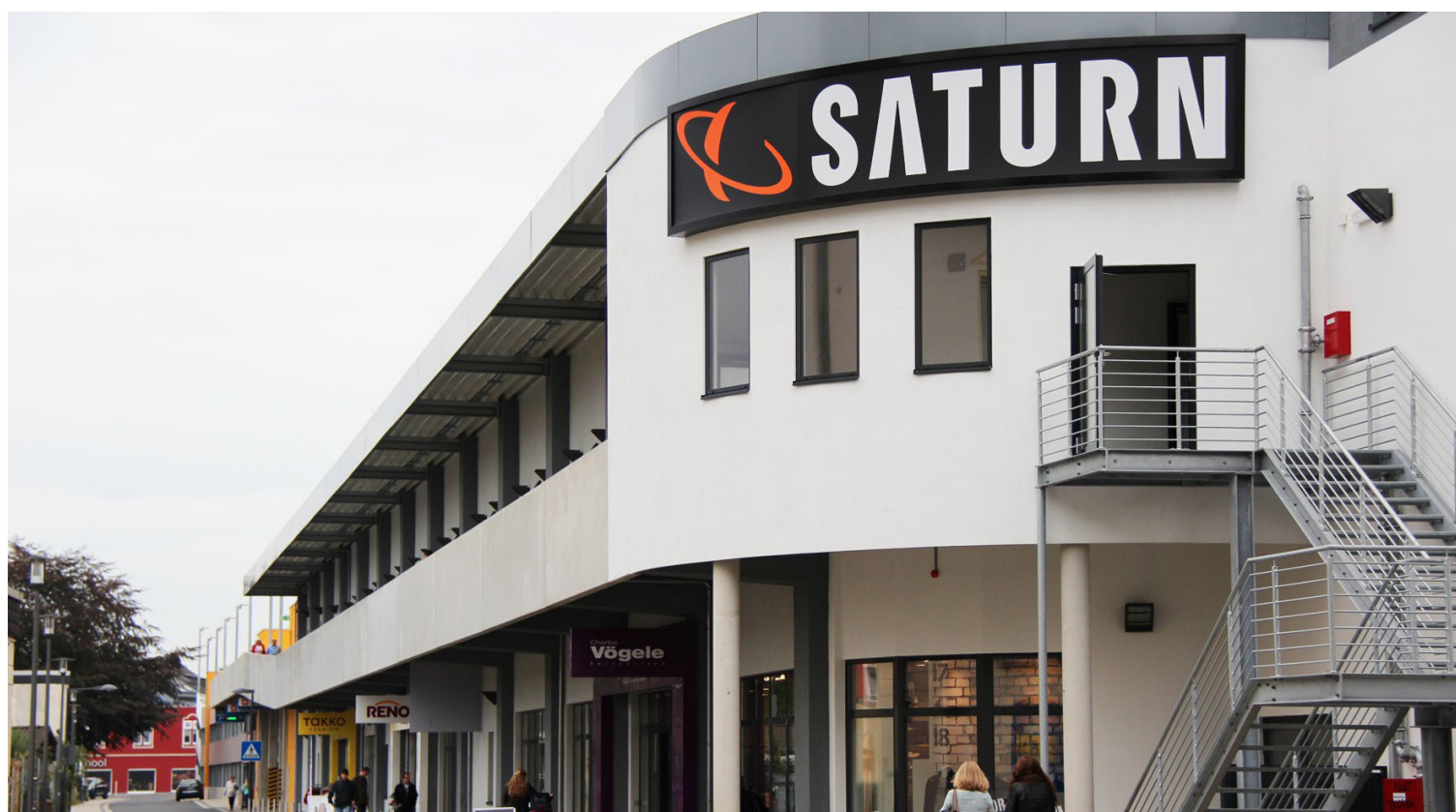
Einkaufszentrum an der Ladestraße in Hennef
