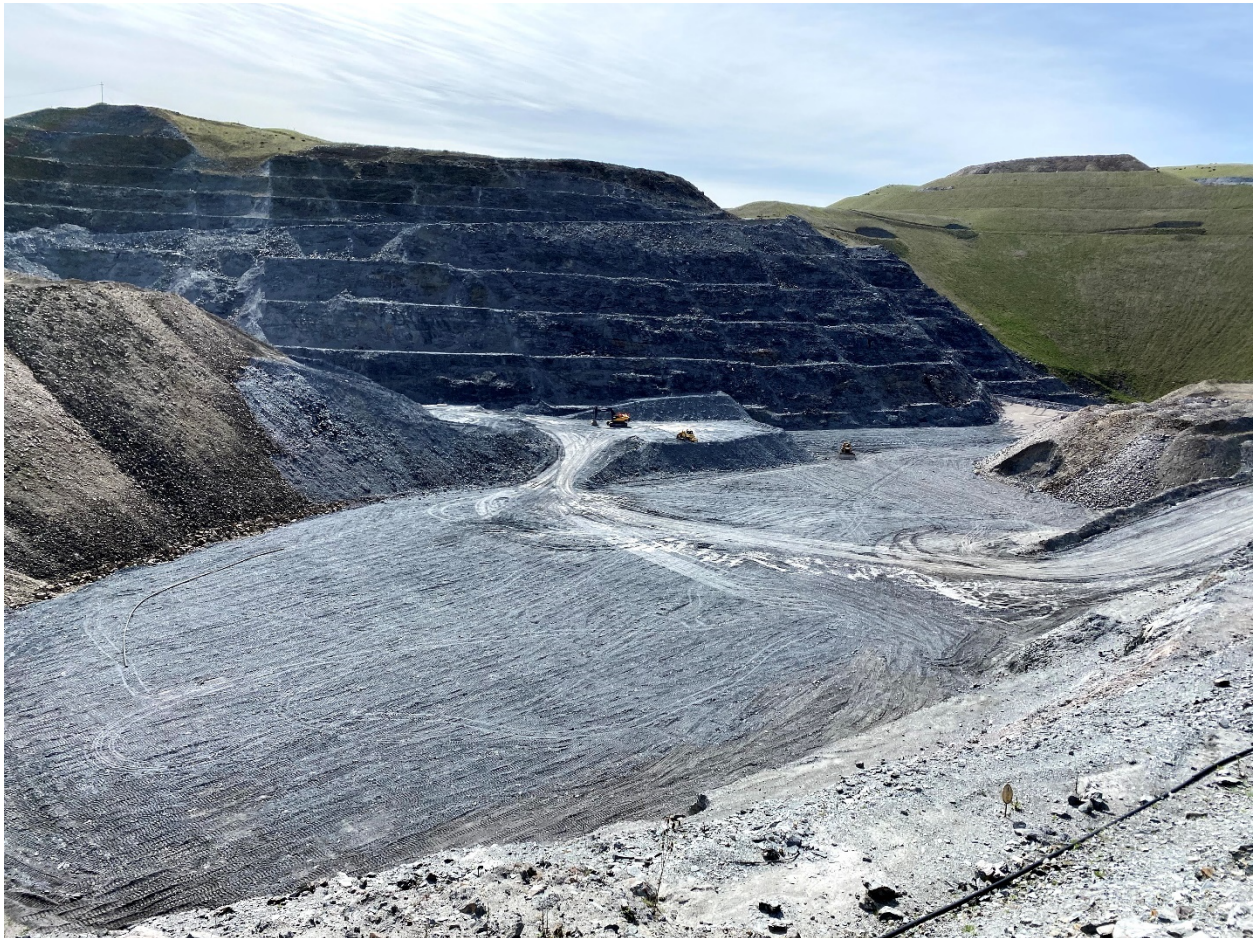
Abbildung 1: Frühe Erdarbeiten am Standort des U-Bahn-Portals Golden Point - Macraes Operation Neuseeland - Dezember 2020.
