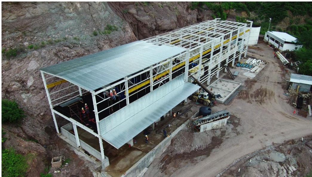
Abbildung 1. Bau des Mhlwerkes in Tahuehueto
