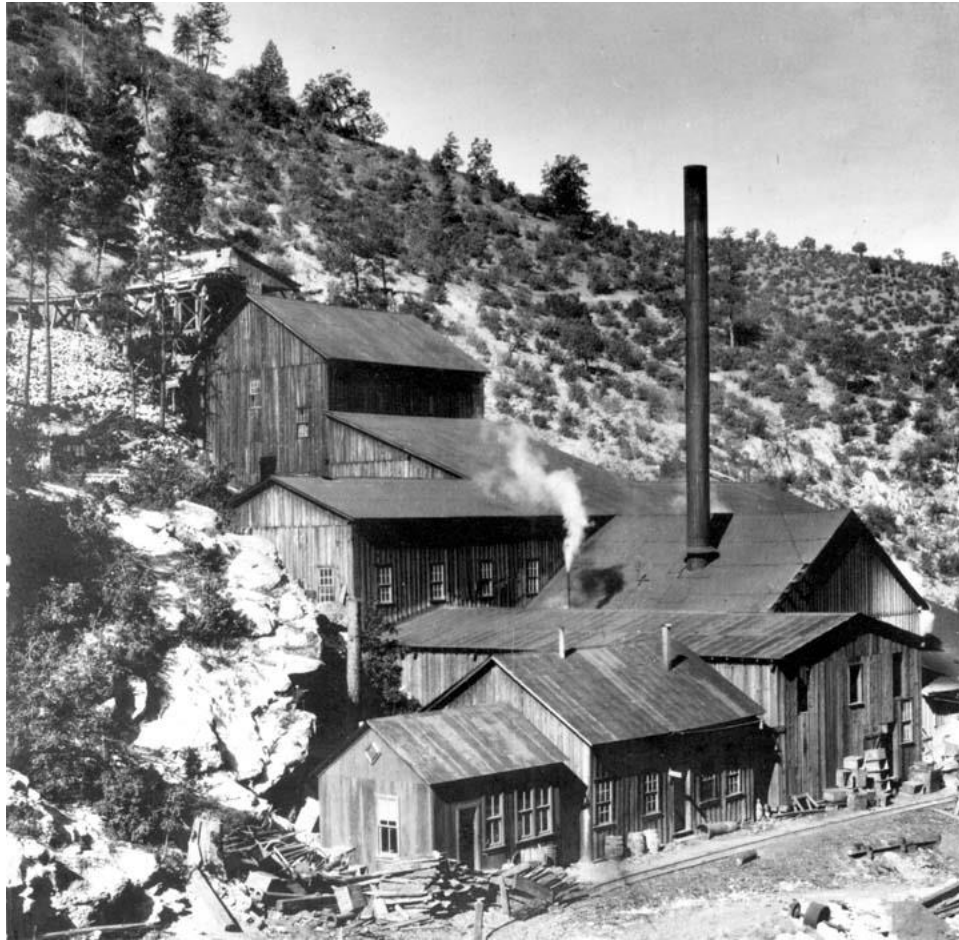
Pochwerk Last Chance, 1905
