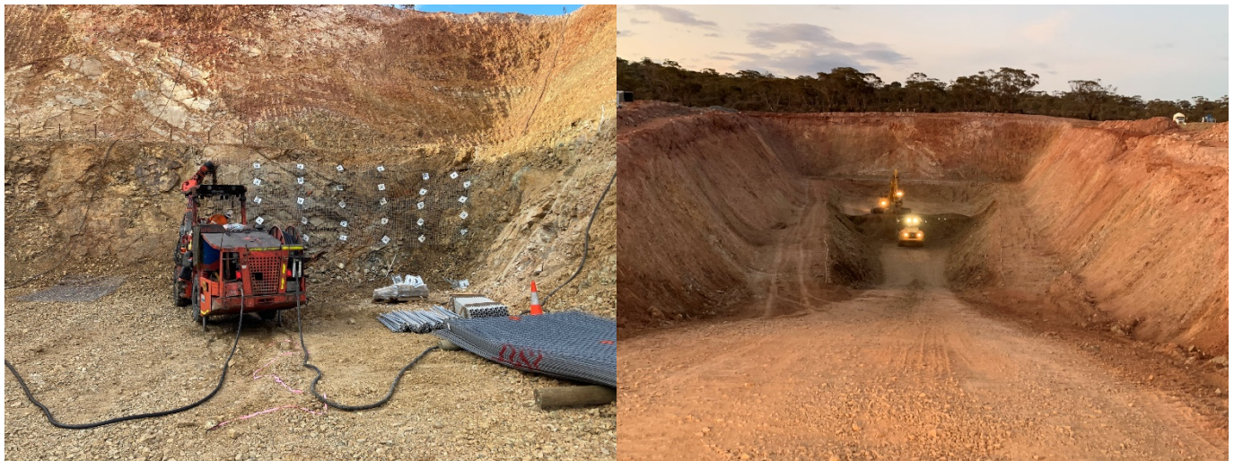
Abbildung 1(a) und 1(b): Portalinstallation in der Beta Hunt Mine (Mai 2022)
