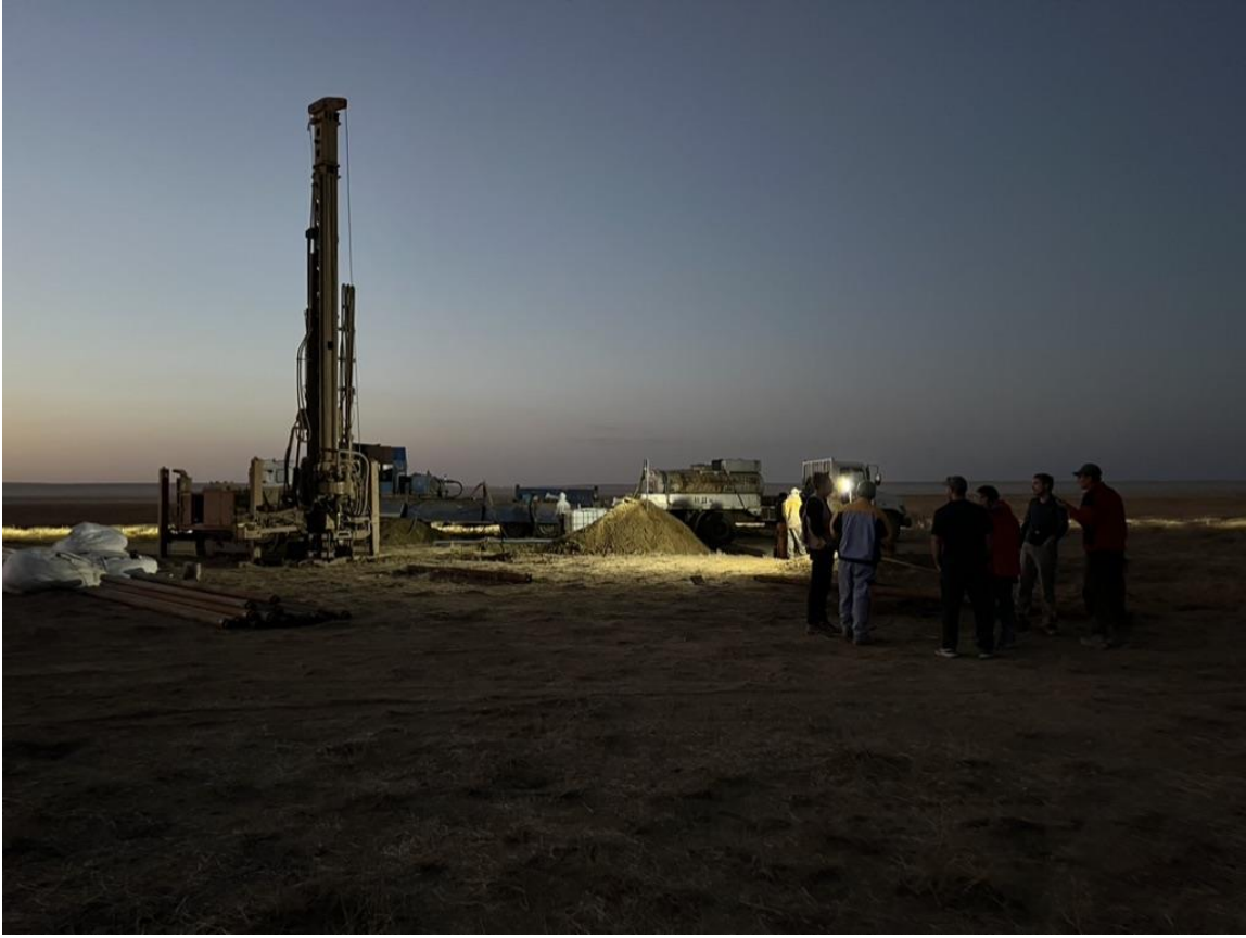
Abbildung 3. Brunnenbohrgerät bei UNWH-01, Urgakh Naran.
